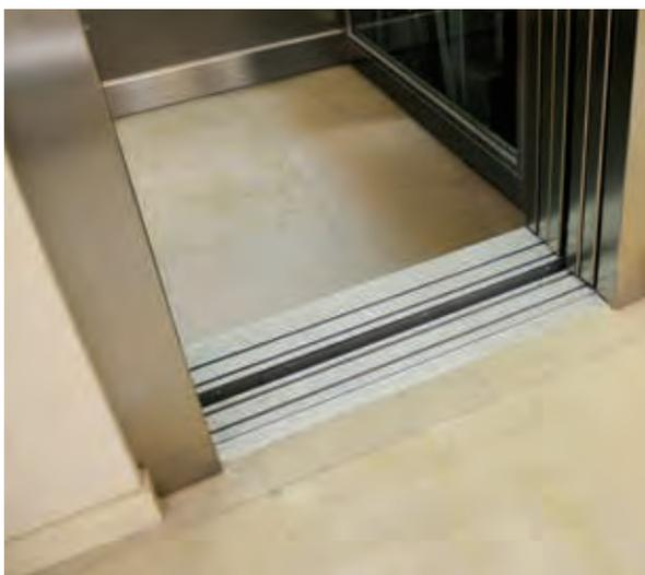
Il **pavimento cabina** può essere lasciato con una predisposizione di 20 millimetri (rientranza), in modo che il cliente possa installare la propria pavimentazione
