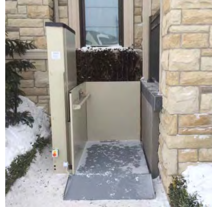
Uscita laterale opzionale nella posizione di fermata superiore
