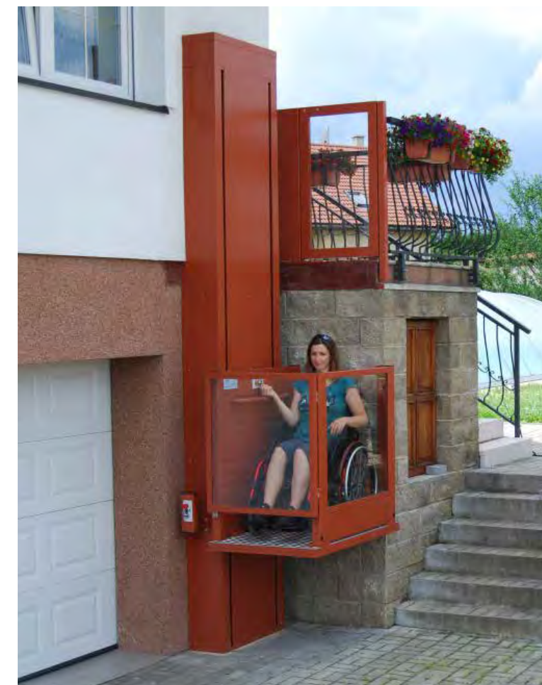
Fissaggio a parete della torretta di azionamento per un'installazione salvaspazio
